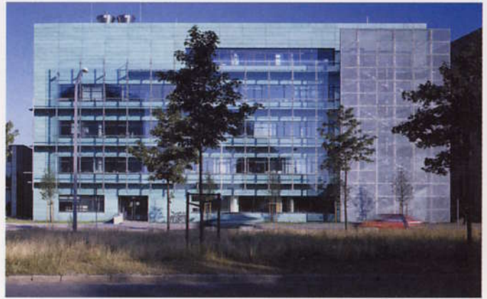
Bild 1. Der feuerverzinkte Screen ist ein wesentliches Gestaltungselement des Max Bergmann Zentrums für Biomaterialien
