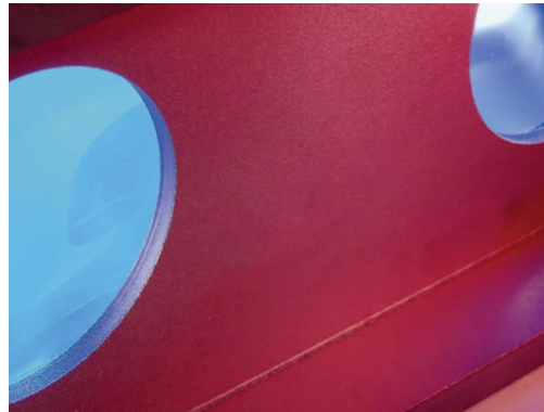
Bild 1. Fast nicht mehr sichtbare Schweißnaht (Ansichtsbreite < von 2 mm) an einem Fassadenprofil; die Lochausschnitte in den Stegen erzielen Transparenz in den ansonsten oft geschlossenen Stegmaterialflanken
