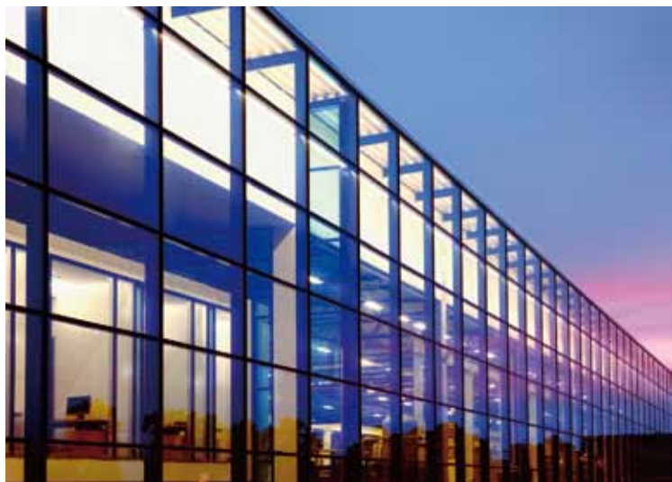
Die Werkshalle der Firma Euroglas in Haldensleben hat eine 3000 m 2 große Glasfassade. Teilweise werden die Dachlasten direkt von der Fassade abgetragen
