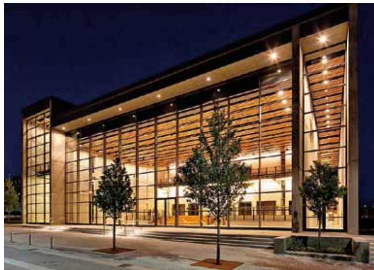
Dallas City Performance Hall – die großen Stützweiten in der Glasfassade wurden ermöglicht durch lasergeschweißte Kastenprofile
